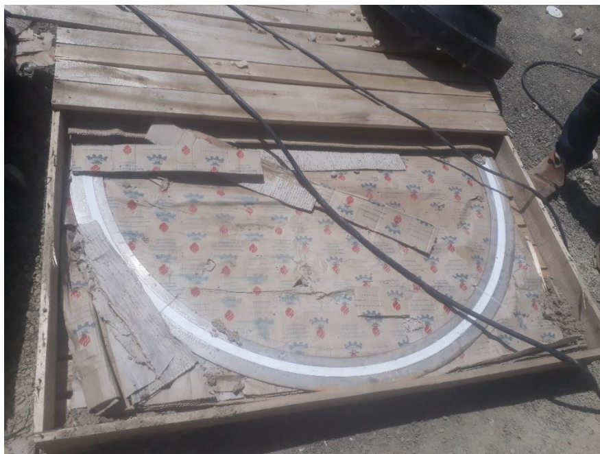
یک نمونه از نگهداری غیر اصولی از گسکت در فضای باز ایستگاه
